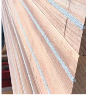
Anti slip voeg. Geen relief in hout toegepast Licht grijs, op fietspad rode kleur toepassen
